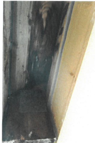
Foto 4 og 5, opfugtninger og skader på trækonstruktioner i tagudhænget, mod havesiden.
