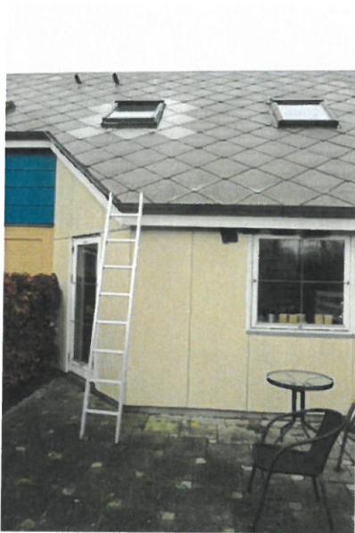
Foto 9, bygningen set fra havesiden.
