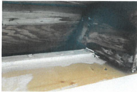
Foto 4 og 5, opfugtninger og skader på trækonstruktioner i tagudhænget, mod havesiden.
