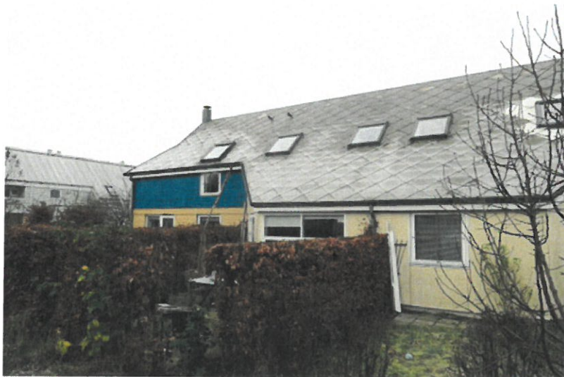
Foto 3, bygningen set fra havesiden.
