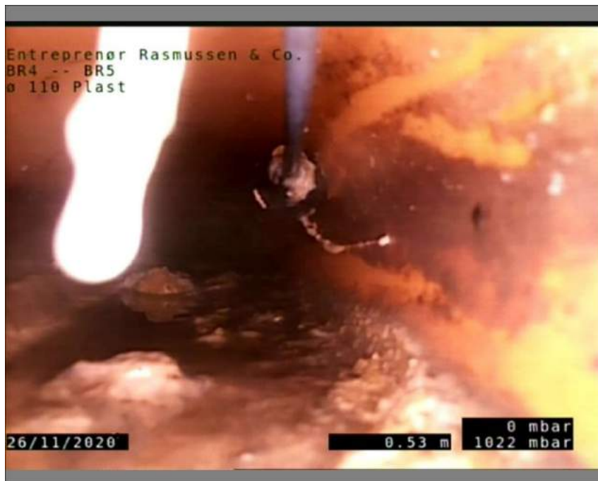
Foto: BR4-BR5-261120-0,53-3-A.JPG 0,53m, Aflejring klasse 3, fra urref 4 til urref 8, Sand/Grus
