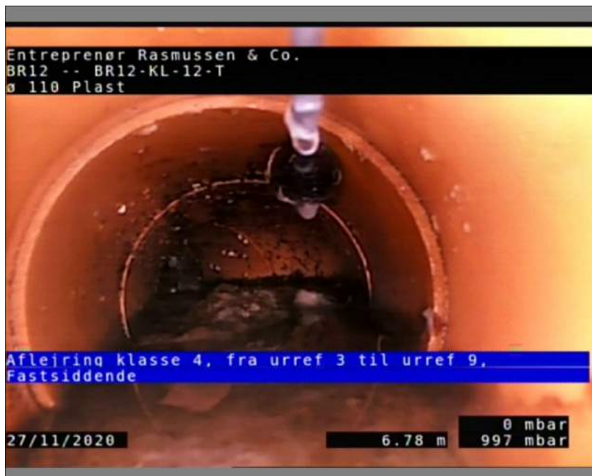
Foto: BR12-BR12-KL-12-T-271120-6,78-8-A.JPG 6,78m, Aflejring klasse 4, fra urref 3 til urref 9, Fastsiddende
