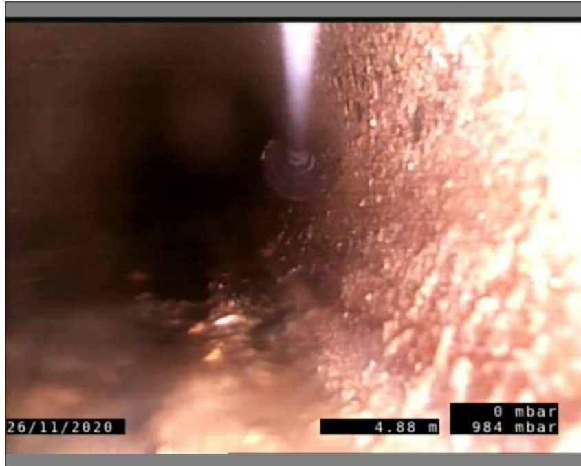
Foto: BR2-BR3-261120-4,88-4-A.JPG 4,88m, Aflejring klasse 3, fra urref 4 til urref 8, Fastsiddende, Start
