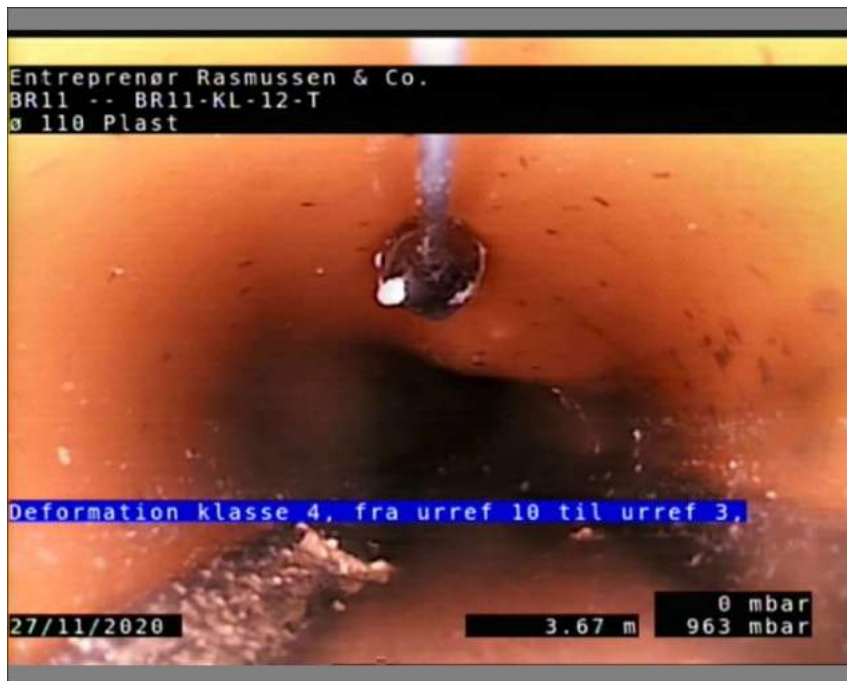
Foto: BR11-BR11-KL-12-T-271120-3,67-2-A.JPG 3,67m, Deformation klasse 4, fra urref 10 til urref 3, Punktdeformation
