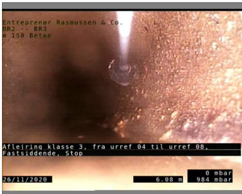
Foto: BR2-BR3-261120-6,08-5-A.JPG 6,08m, Aflejring klasse 3, fra urref 04 til urref 08, Fastsiddende, Stop
