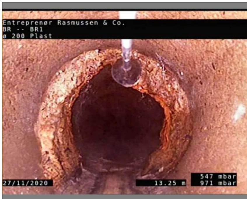
Foto: BR-BR1-271120-13,25-5-A.JPG 13,25m, Belægninger klasse 3, fra urref 12 til urref 00, Udfældninger, I samling
