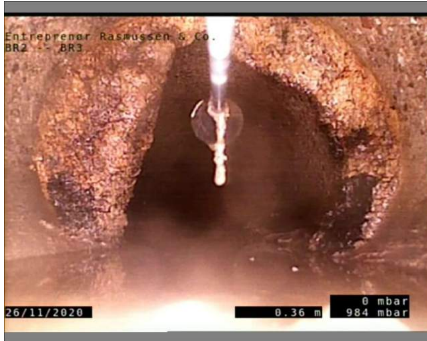
Foto: BR2-BR3-261120-0,36-2-A.JPG 0,36m, Belægninger klasse 4, fra urref 12 til urref 00, Udfældninger, I samling
