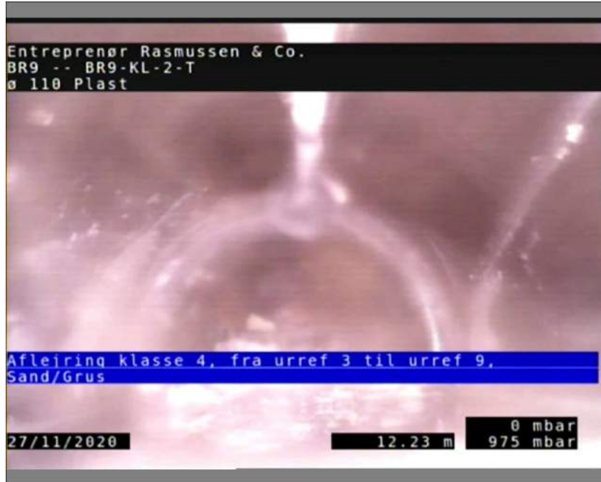
Foto: BR9-BR9-KL-2-T-271120-12,23-9-A.JPG 12,23m, Aflejring klasse 4, fra urref 3 til urref 9, Sand/Grus
